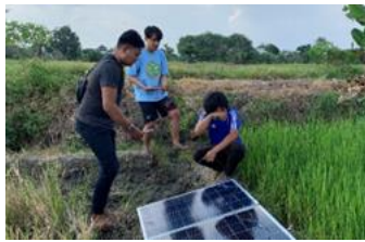
(a) Instalasi sel surya
