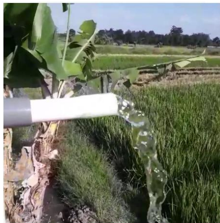
Gambar 4.3. Aliran air pada uji coba pompa air dc bersumber energi PLTS di lapangan.
