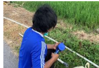
(b) Pemasangan flow meter pada pipa
