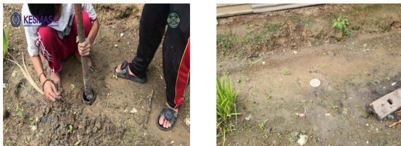
Gambar 1. Pemasangan Percontohan Lubang Resapan Biopori
