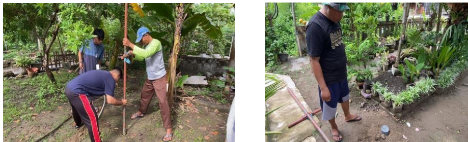
Gambar 5. Pembuatan Biopori Warga
