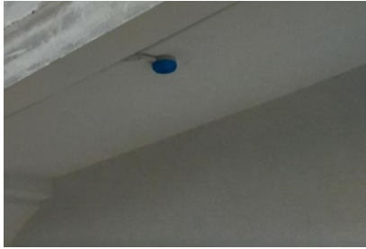
Gambar 4. Heat Detector (Sumber: Dokumentasi Pribadi 2021)
