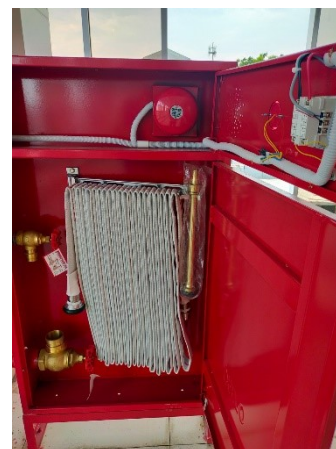
Gambar 3. Alarm Kebakaran (Sumber: Dokumentasi Pribadi 2021)
