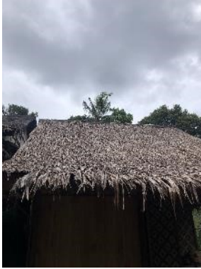
Gambar 5. Atap Rumah Tradisional (Sumber: Dokumentasi Pribadi, 2021)
