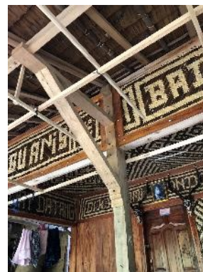
Gambar 8. Pemakaian Paku (Sumber: Dokumentasi Pribadi, 2021)
