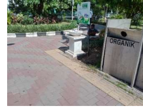
Gambar 5 Kondisi Eksisting Jalur Pemandu Taman Jaya Wijaya
