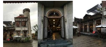
Gambar 1. Minarets Classic Coffe Sumber : Dokumentasi Penulis,2020
