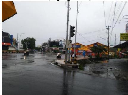
Gambar 5. Jalan Piere Tendeon setelah pelebaran jalan (sumber: Dokumen Penulis (2020) )
