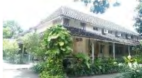
Gambar 4. Atap limasan (sumber: dokumen pribadi, 2019)
