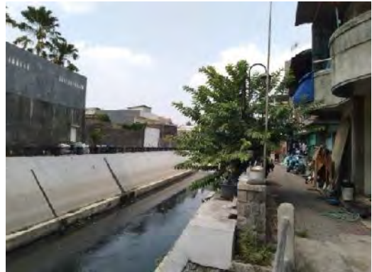
Gambar 8. Keadaan bantaran Kali Pepe di segmen 2 (sumber: Dokumen Istimewa, 2019)
