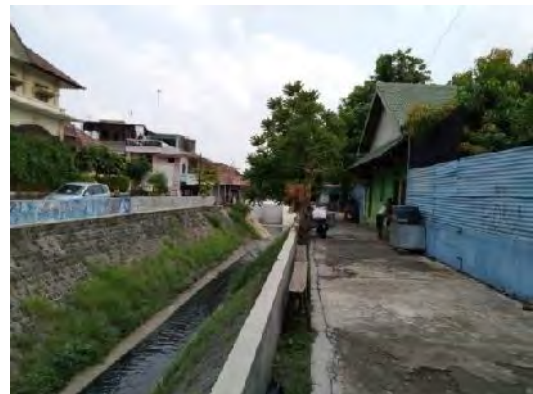
Gambar 10. Keadaan bantaran Kali Pepe di segmen 3 (sumber: Dokumen Istimewa, 2019)
