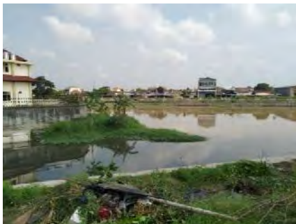
Gambar 6. Keadaan bantaran Kali Pepe di segmen 1 (sumber: Dokumen Istimewa, 2019)
