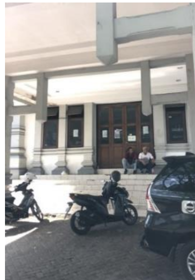
Gambar 15. Area Depan Pintu Masuk Gedung (Sumber: Dokumentasi Pribadi Penulis, 2022)
