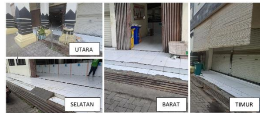
Gambar 6. Ramp dan Teras Pasar Tanggul Surakarta (Sumber : Dokumentasi Pribadi)
