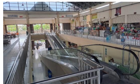
Gambar 7. Travelator Pasar Tanggul Surakarta Sumber : Dokumentasi Pribadi
