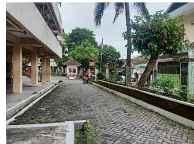
Gambar 13. Pos satpam (Sumber: Dokumentasi pribadi, 2022)
