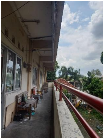
Gambar 9. Shading bangunan (Sumber: Dokumentasi pribadi, 2022)
