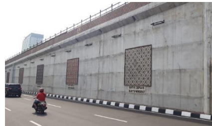
Gambar 2. Area Dinding Flyover yang Dihiasi Ornamen Batik (Sumber: Dokumentasi Pribadi, 2023)
