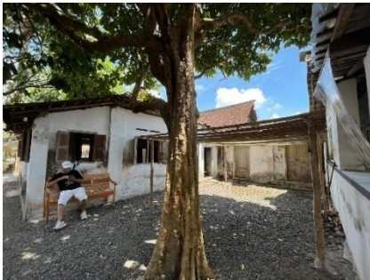
Gambar 5. Bangunan utama Bunker Laweyan Solo (Sumber: Dokumen Penulis, 2022)
