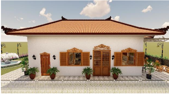
Gambar 14. Fasad Bangunan Bunker Laweyan Solo setelah diterapkan konsep Adaptive Reuse (sumber: Dokumen Penulis, 2022)
