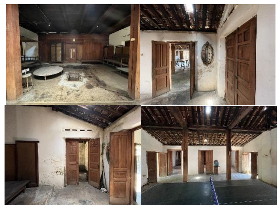
Gambar 9. Kondisi interior bangunan rumah Bunker Laweyan Solo (sumber: Dokumen Penulis, 2022)
