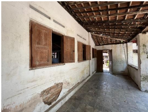
Gambar 6. Kondisi pintu dan Jendela Rumah Bunker Laweyan Solo (Sumber: Dokumen Penulis, 2022)
