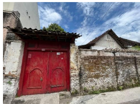
Gambar 4. Gerbang Rumah Bunker Laweyan Solo (Sumber: Dokumen Penulis, 2022)
