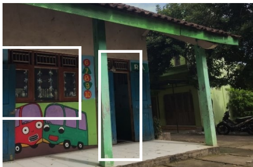
Gambar 4. Bukaan Jendela dan Pintu Sisi Utara (sumber. Dokumentasi Penulis, 2022)
