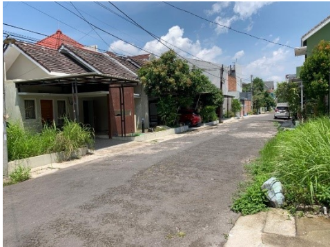
Gambar 13. Pemandangan Perumahan dari Jalan Utama (Sumber: Survei Penulis November 2022)
