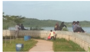
Gambar 19. Pagar Pembatas (Sumber: Dokumentasi Penulis, 2022)
