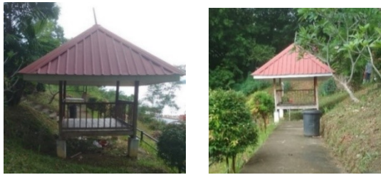
Gambar 12. Gazebo (Sumber: Dokumentasi Penulis, 2022)
