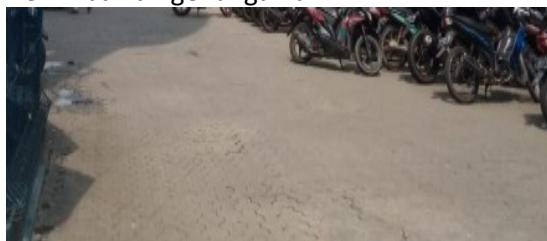
Gambar 11. Perkerasan di Area Parkir (sumber: Dokumentasi Penulis, 2022)
