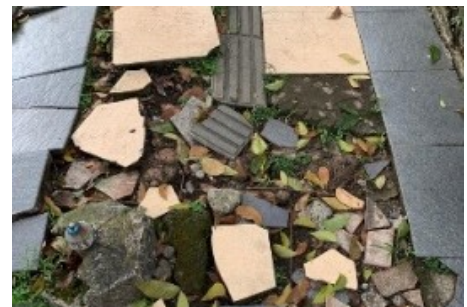
Gambar 10. Kondisi guiding block pada jalur pedestrian (sumber: Dokumentasi penulis, 2022)
