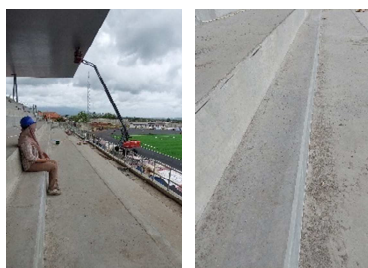
Gambar 8. Kondisi Tribun (sumber: Dokumen Pribadi, 2022)
