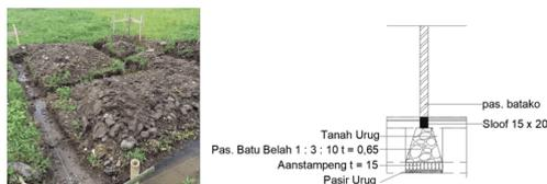
**Gambar 15. Proses Bowplank dan pondasi (sumber: Dokumentasi pribadi, 2022)**
