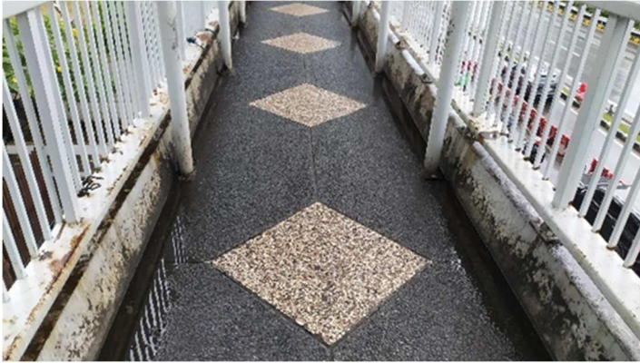
Gambar 13. Jalur air yang tidak mengalir dengan baik pada JPO 4 dan 5 (sumber: Dokumentasi Penulis, 2022)
