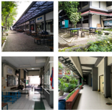
Gambar 1. Communal area pada Gedung F, H, J, dan G (sumber: Dokumentasi Pribadi, 2022)
