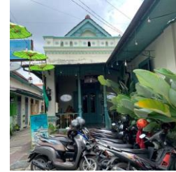
Gambar 3. Rumah ketib Anom II (sumber: Dokumentasi Pribadi, 2022)
