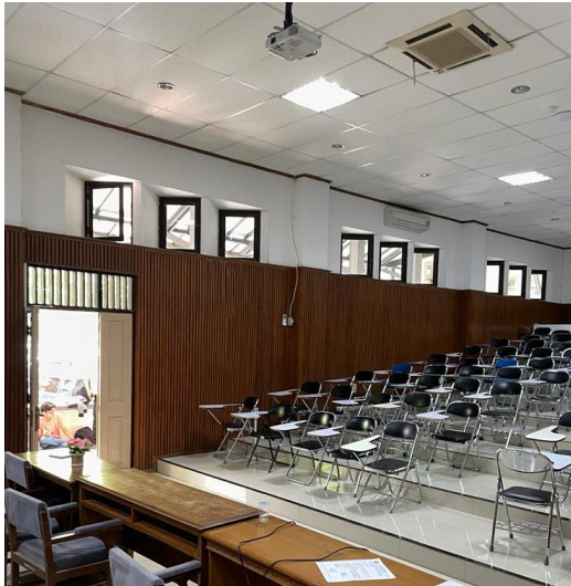
Gambar 4. Dinding Ruang Seminar (Sumber: Dokumen Penulis, 2023)
