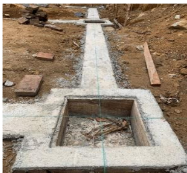
Gambar 5. Pengerjaan Pondasi RUSPIN (sumber: Dokumentasi Pribadi, 2023)
