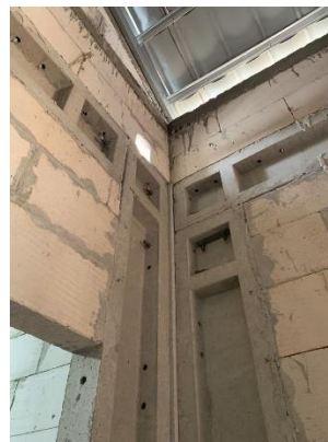
Gambar 7. Hasil dari Pemasangan Panel Instan (sumber: Dokumentasi Pribadi, 2023)
