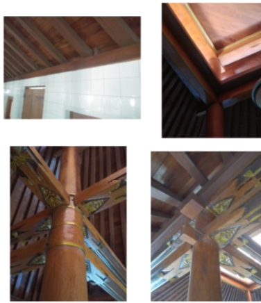
Gambar 6. Detail Struktur Masjid (Sumber: Dokumen Pribadi, 2021)
