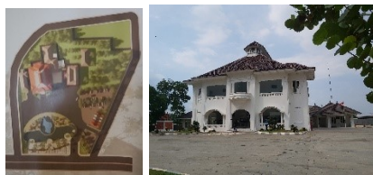
Gambar 6. Tapak dan Eksterior Gedung Juang Tambun (Sumber: Dokumentasi Penulis, 2021)
