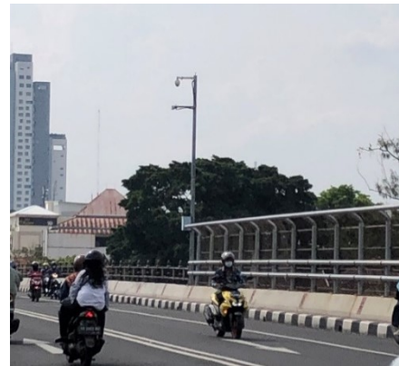
Gambar 9. CCTV Flyover Purwosari (Sumber: Dokumen Pribadi, 2021)
