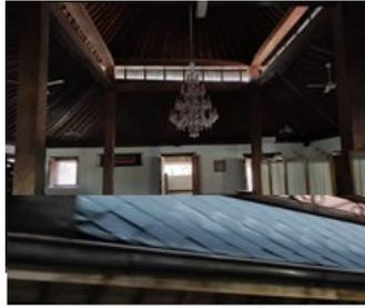
**Gambar 2. Plafon Kayu Jati dan Atap Aspal atau Bitumen**
