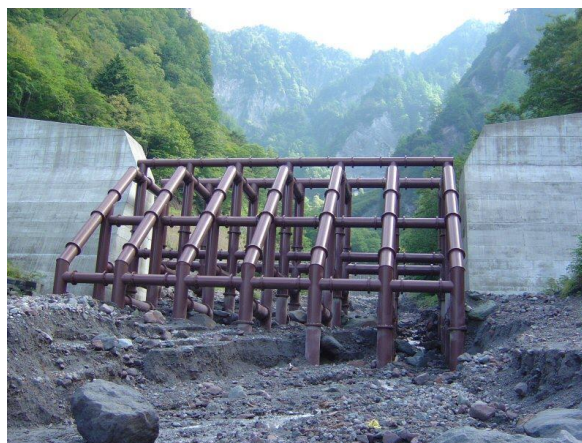
Gambar 5. Open-type Sabo Dam (Kantoush dan Sumi, 2010)
