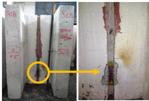
Gambar 8. Spalling pada benda uji 50B
