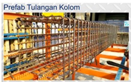
Gambar 6. Hasil perakitan dengan Prefab Assembly Table
