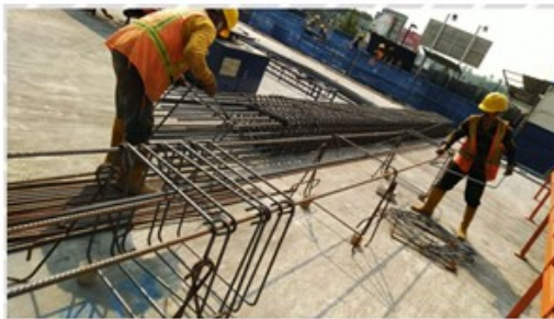
Gambar 1. Proses perakitan/prefabrikasi tulangan kolom cara konvensional
