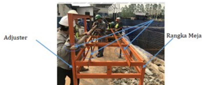
Gambar 4. Konstruksi Prefab Assembly Table
