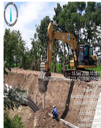
Gambar 5, Pemasangan Minipile
