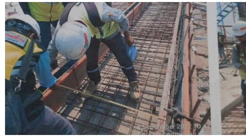
Gambar 4. Pengecekan tulangan untuk pembesian plat lantai
