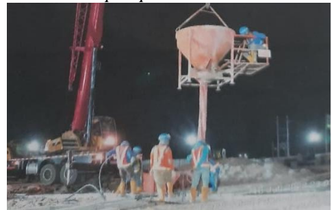
Gambar 5. Pengecoran plat lantai
