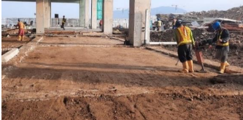
Gambar 2. Pemadatan timbunan dengan mesin stamper
