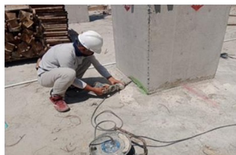
Gambar 4. Tahap pembersihan permukaan beton (sumber: Dokumentasi)
