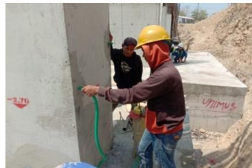
Gambar 5. Pelaksanaan injeksi kolom (sumber: dokumentasi)
