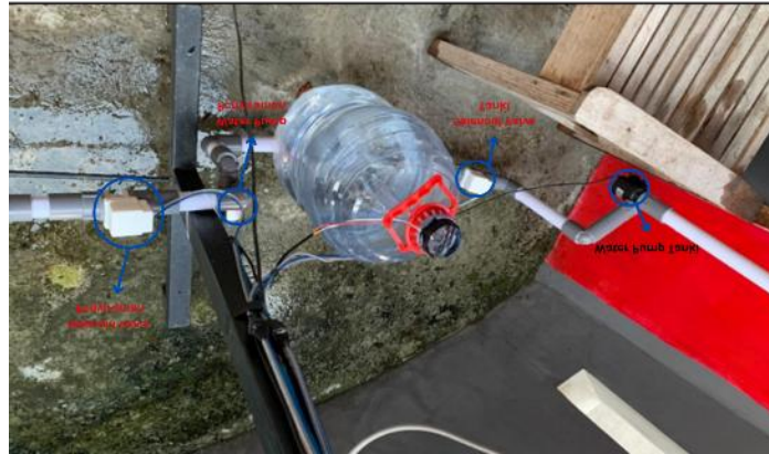
Gambar 3.5. Pemasangan pompa dan selenoid valve .
