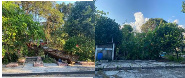
Gambar 6. Kondisi IPAL Komunal Sudah Tidak Beroperasi.
