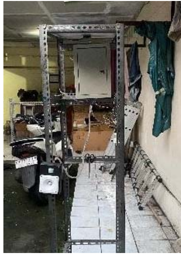
Gambar 3. Pembangkit Listrik Tenaga Surya
