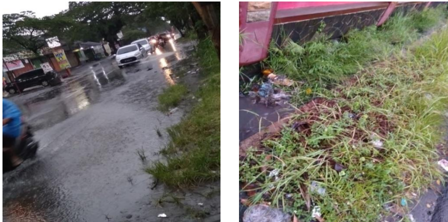
Gambar 5. Keadaan Jalan Saat Hujan dan Saluran Drainase
