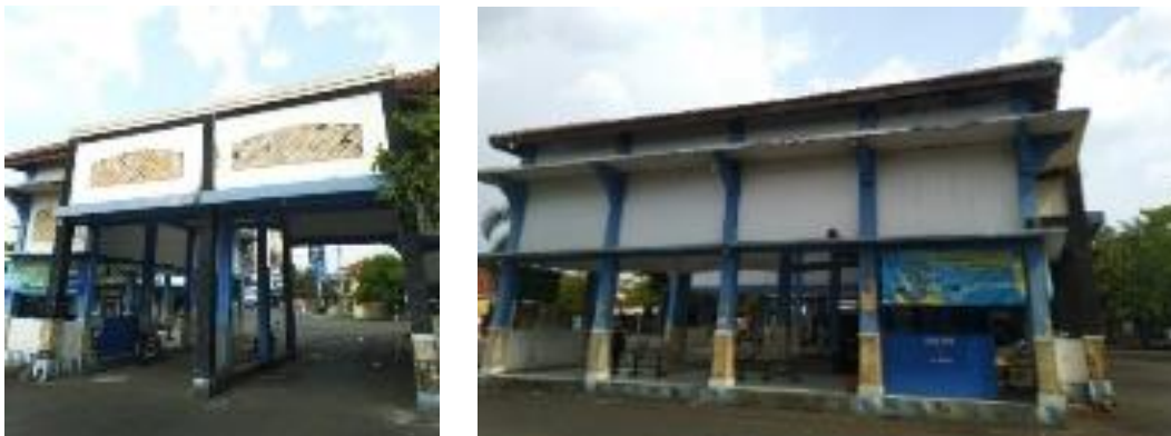
Gambar 4. Fasad Terminal Tegalgede Karanganyar
