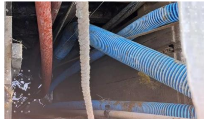
Gambar 7. Penyedotan Lubang Tambang Menggunakan Pompa
