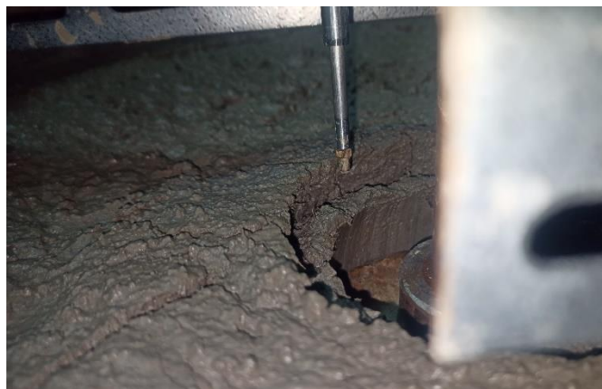
Gambar 9. Footing setelah pembebanan pada tanah lempung lunak tanpa adanya perkuatan
