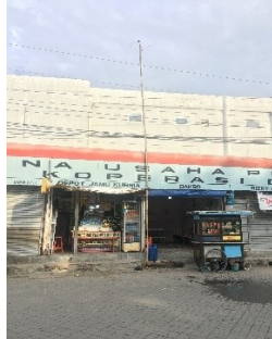
Gambar 2. Pertokoan/shelter. (Sumber: Penulis, 2021)
