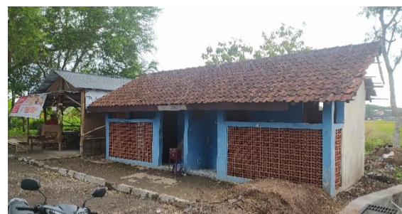
Gambar 4. Toilet (Sumber: Dokumentasi Pribadi, 2021)
