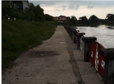
Gambar 15. Area A yang Merupakan Area Paling Ujung dari Bendungan Tirtonadi
