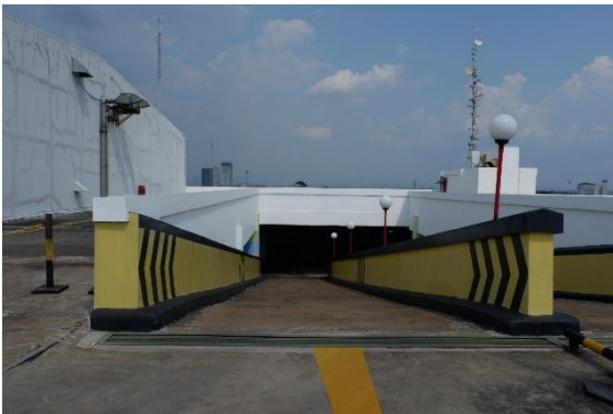
Gambar 5. Ramp kendaraan menuju rooftop (Sumber: Dokumentasi penulis, 2021)
