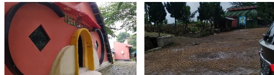
Gambar 4. Toilet & Area Parkir (Sumber: Penulis, 2021)
