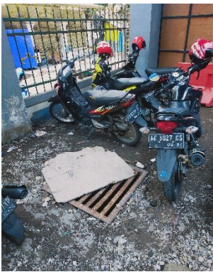
Gambar 6. Kondisi Area Parkir Motor (Sumber: Dokumentasi Penulis, 2021)
