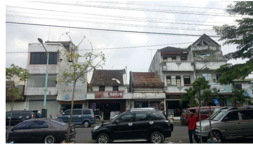
Gambar 7 Ketinggian antar bangunan yang berbeda (Sumber : Dokumen Pribadi, 2020)
